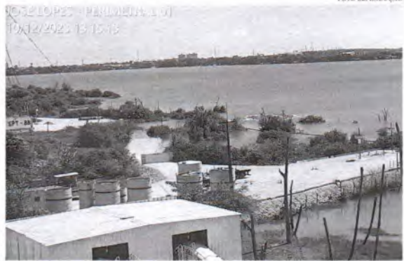
A área do rompimento está localizada sob a lagoa Mundial. Com isso, a água deve ficar altamente salinizada
