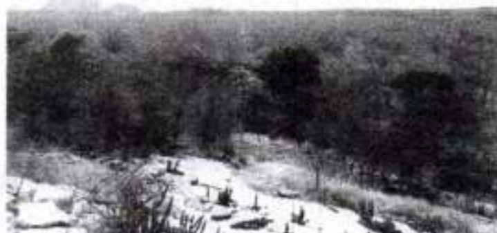
Foto 01-Início do barramento, Fonte: Vistoria Técnica.
