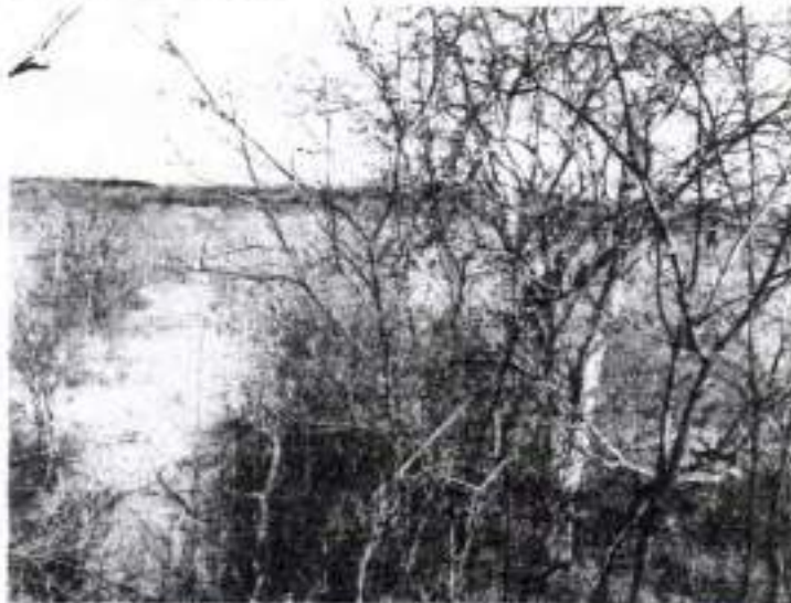
Foto 03-Fim do barramento. Fonte: Vitoria Técnica.
