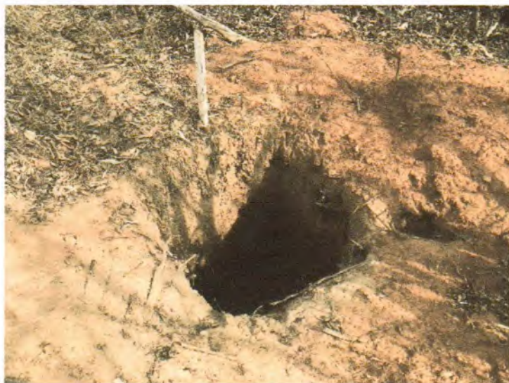
Foto 04-Escavação indicativa mostrando a localização do vertedouro. Fonte: Vistoria Técnica.
