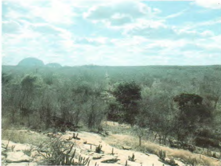
Foto 01-Início do barramento. Fonte: Vistoria Técnica.
