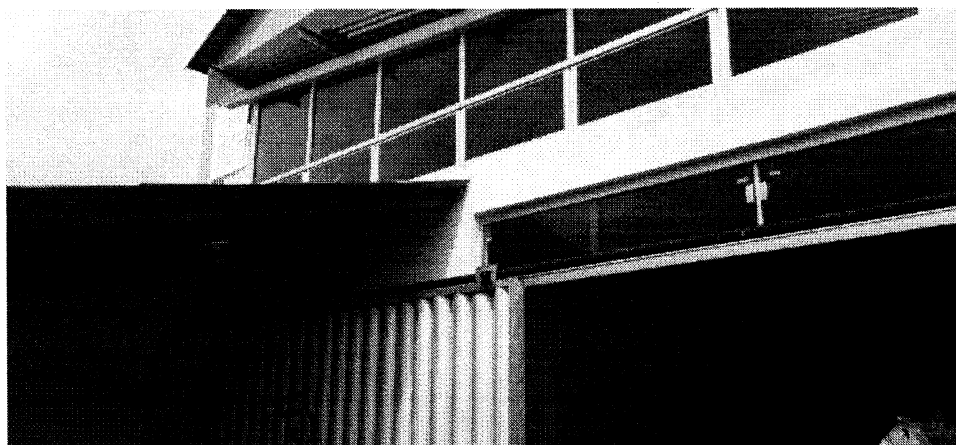
Figura 06 – Área externa vista para janelas/vidraças do galpão.
