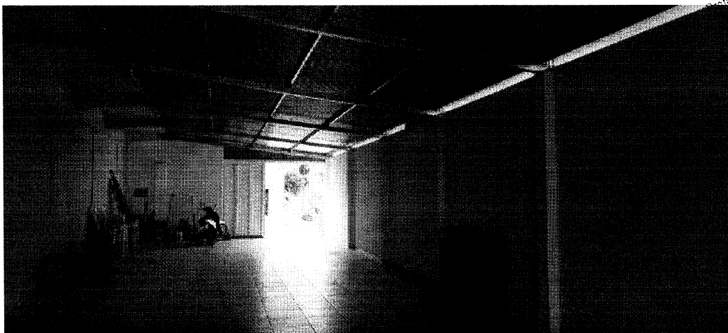
Figura 04 – Galpão vista interna (sentido fundo-fachada).
