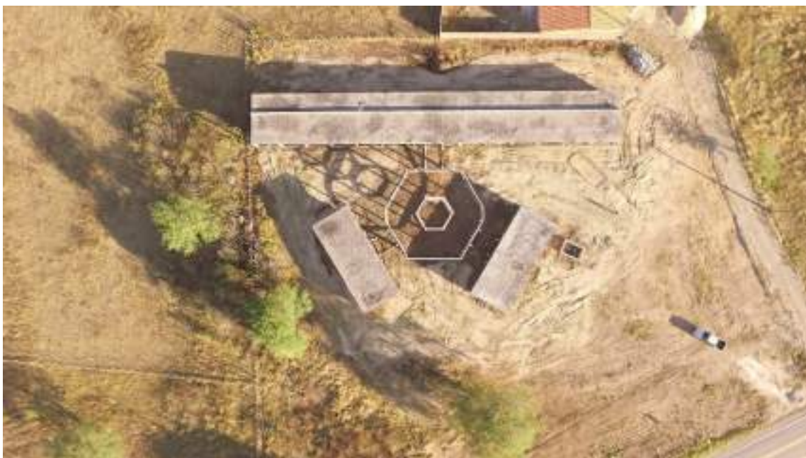
Figura 3 - Vista aérea - Estruturas Existentes.
