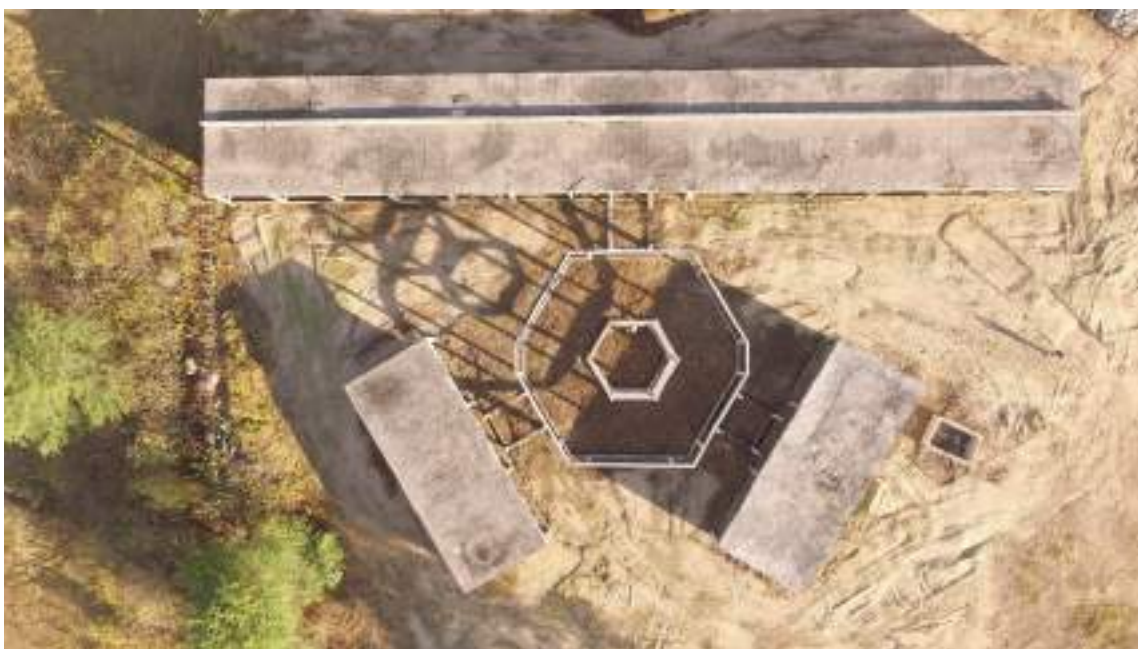
Figura 4 - Vista aérea - Estruturas Existentes.
