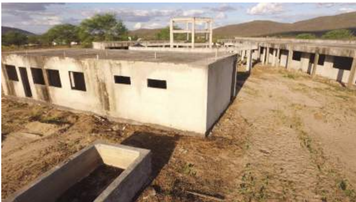
Figura 1 - Local da Obra / Prédios existentes.
