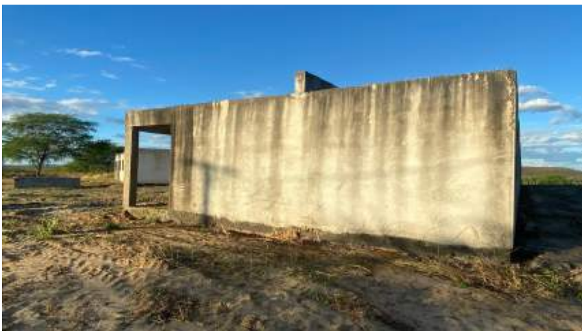
Figura 8 - Vista Lateral do Bloco.
