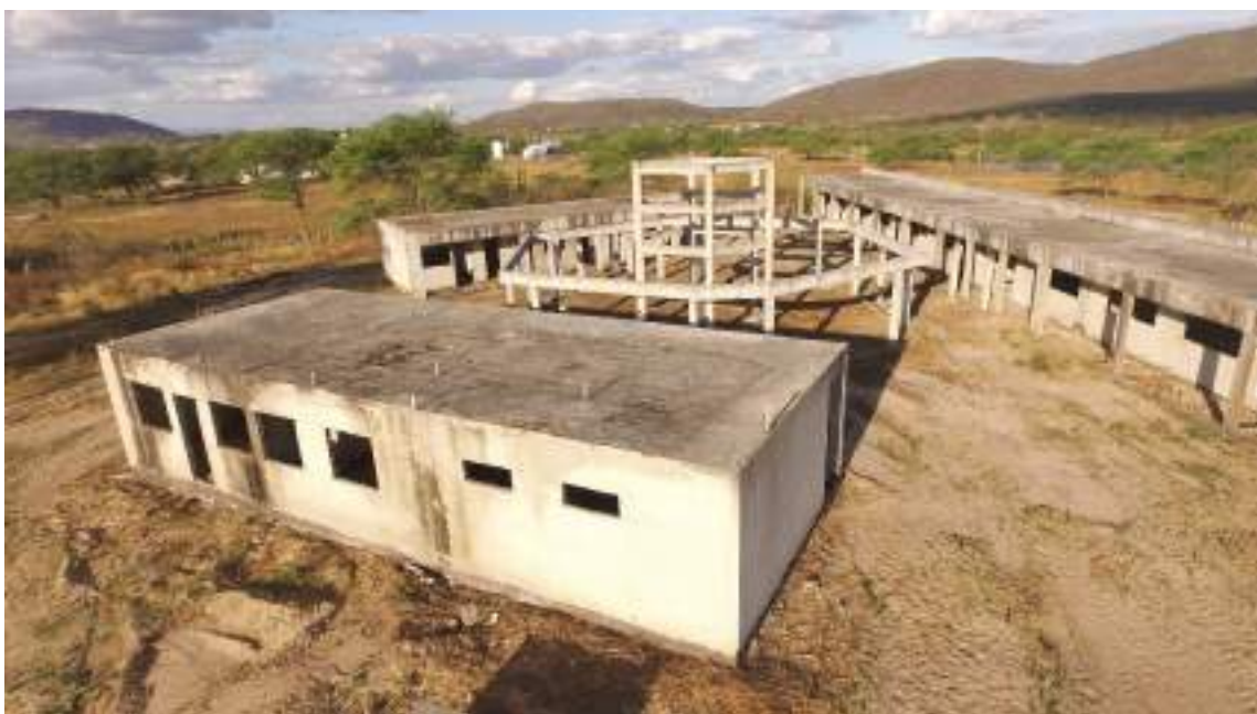
Figura 2 - Local da Obra - Estruturas existentes.
