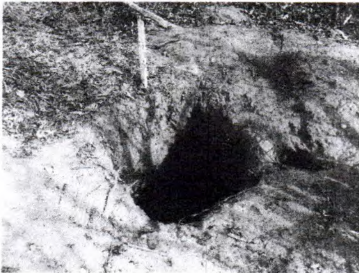
Foto 04-Escavação indicativa mostrando a localização do vertedouro. Fonte: Vistoria Técnica.
