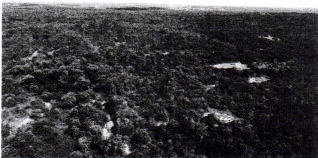
Visão geral da área onde será construído o açude
