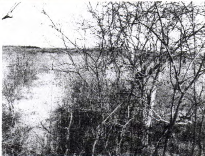
Foto 03-Fim do barramento. Fonte: Vistoria Técnica.
