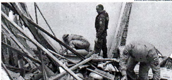
Todos os feridos do primeiro acidente estavam dentro do estabelecimento no momento do desabamento
