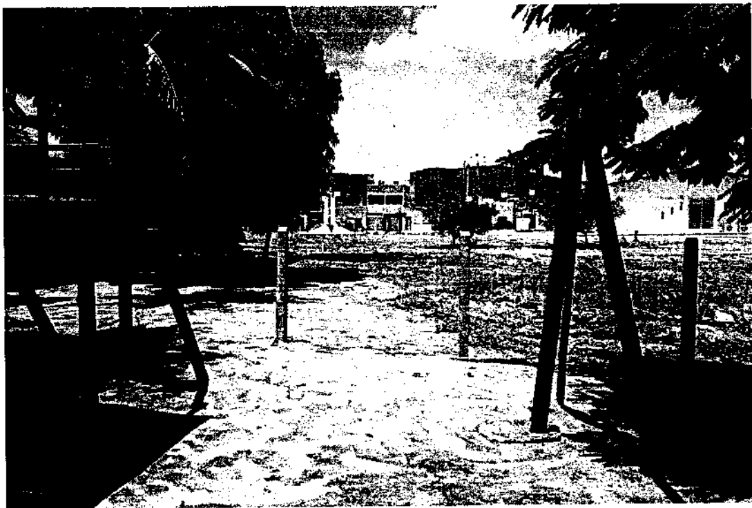
LOCAL DA AMPLIAÇÃO
